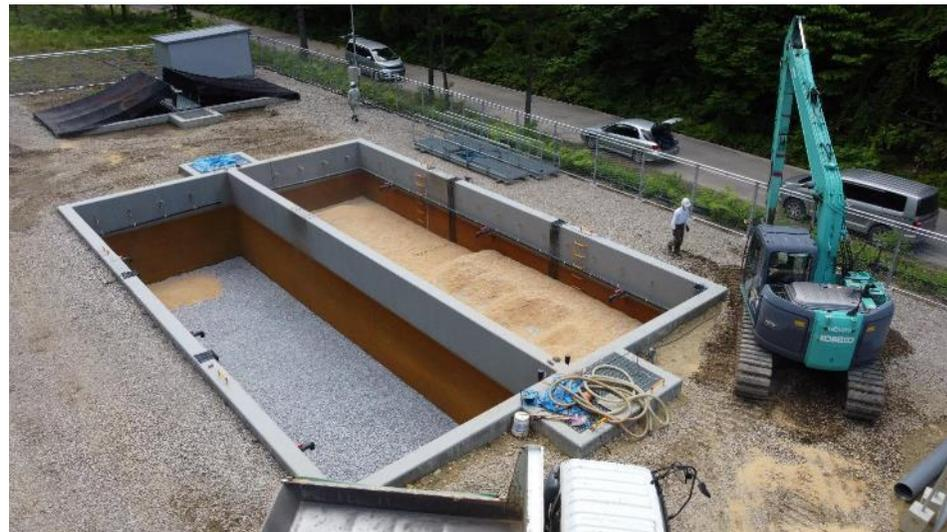
嫌気反応槽内容物混合、充填作業の様子
